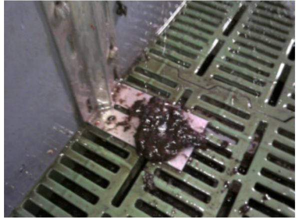
Absatz nach Leitungsspülung
