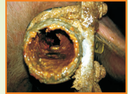
Stan przewodu poidłowego w oborze
